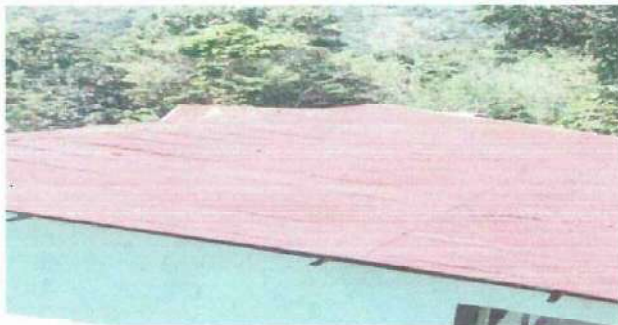
Foto 3: SUSTITUCION DE LAMINA TROQUELADA CALIBRE 26 ALUZINC
