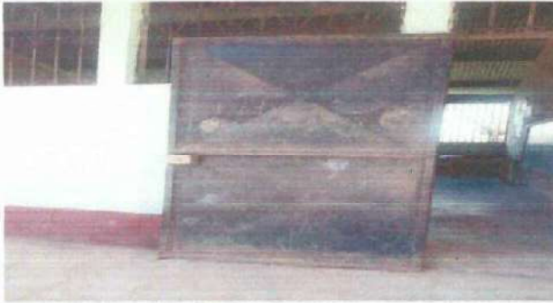
Foto1: SUSTITUCION DE PUERTAS. MODULO 1,2,3, BODEGA Y DIRECCIÓN
