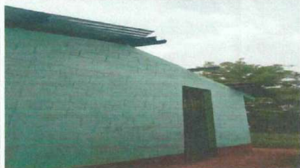
Foto 4: SUSTITUCION DE LAMINA TROQUELADA CALIBRE 26 ALUZINC
