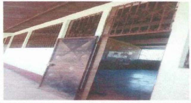
Foto 2: SUSTITUCION DE PUERTAS. MODULO 1,2,3, BODEGA Y DIRECCIÓN
